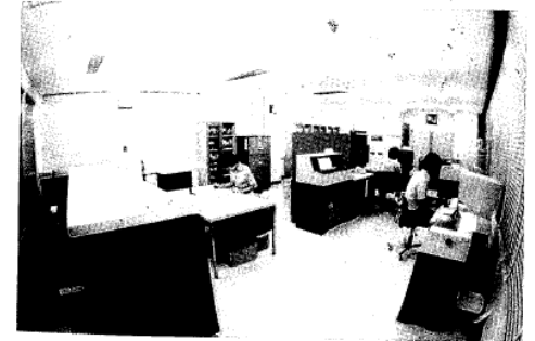
昭和 52(1977)年 汎用コンピュータ導入当時のマシンルーム
