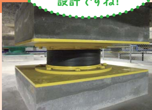
▲免震装置に組み込まれる積層ゴム
