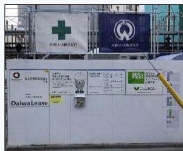
工事看板 イメージ
