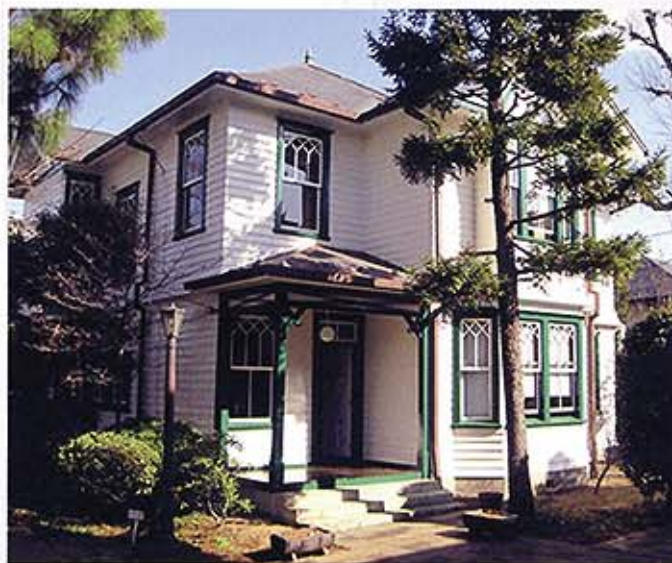
修繕後の旧宣教師館です。
