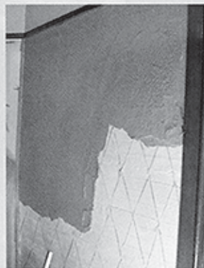
中塗り作業。砂を入れた漆喰を塗ります。
