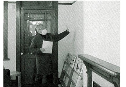
▲修繕が行われた旧教会事務所の北壁
