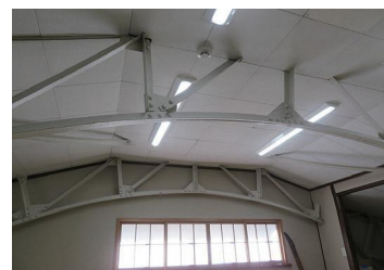
鉄骨トラスアーチ架構(書斎棟2階)
