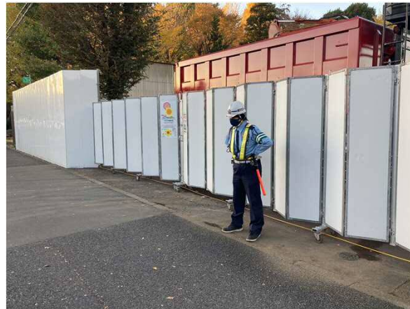
工事中ゲート 交通誘導員
