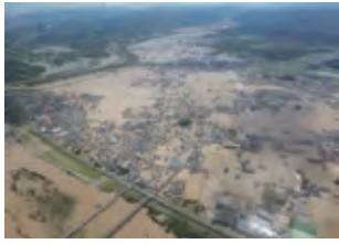
平成30(2018)年7月豪雨(西日本) (高梁川水系小田川の氾濫) 出典:国土交通省「水害レポート 2018」
