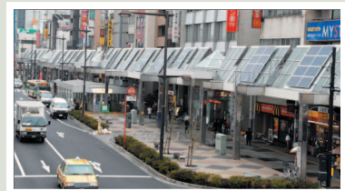
アーケードには、全長270メートル、計188枚のソーラーパネルが設置され、CO2削減に大きな効果をあげている。
