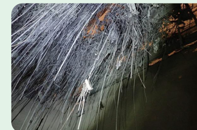
焼却炉内部に絡まった不燃物
