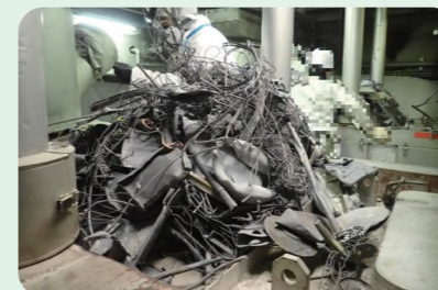
焼却炉から出てきた不燃物
