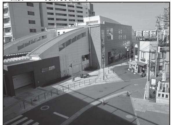
図表 2-5-4 完成写真(北口)
