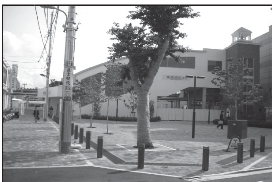
図表 2-5-3 東長崎駅完成写真 北口
