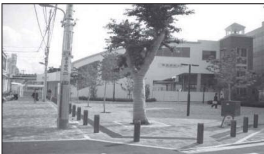
図表 2-5-5 東長崎駅完成写真 北口
