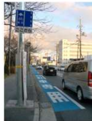
写真Ⅱ-7 道路標識「普通自転車専用通行帯 (327の4の2)」と道路標示「専用通行帯 (109の6)」を設置した事例
