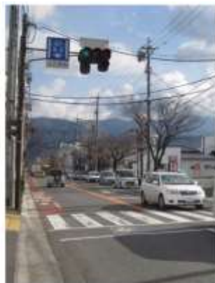
写真Ⅱ-6 道路標識「専用通行帯 (327の4)」と道路標示「専用通行帯 (109の6)」を設置した事例
