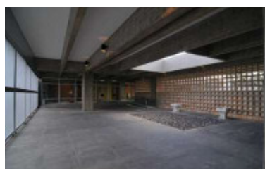
意匠に配慮しながら柱を補強しました。
