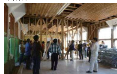
耐震補強工事中に現場公開を行いました。
