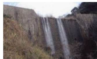
五助堰堤（兵庫県）
