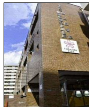
駒込図書館入口
