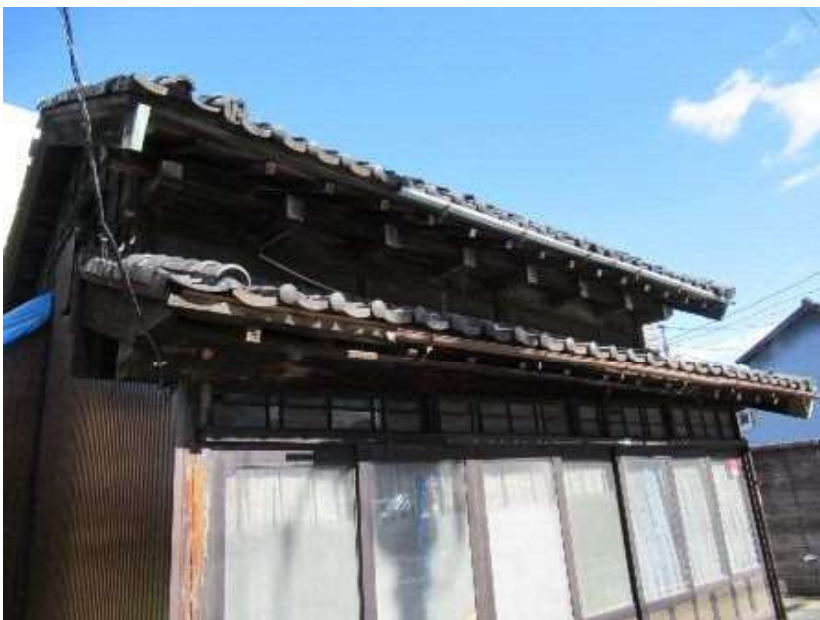
榎本家事務所棟 つし二階出桁造り
