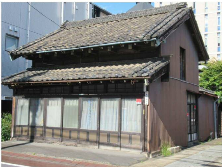
榎本家事務所棟 東南面
