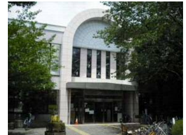
上池袋図書館入口
