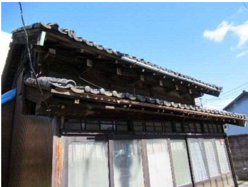
榎本家事務所棟 つし二階出桁造り
