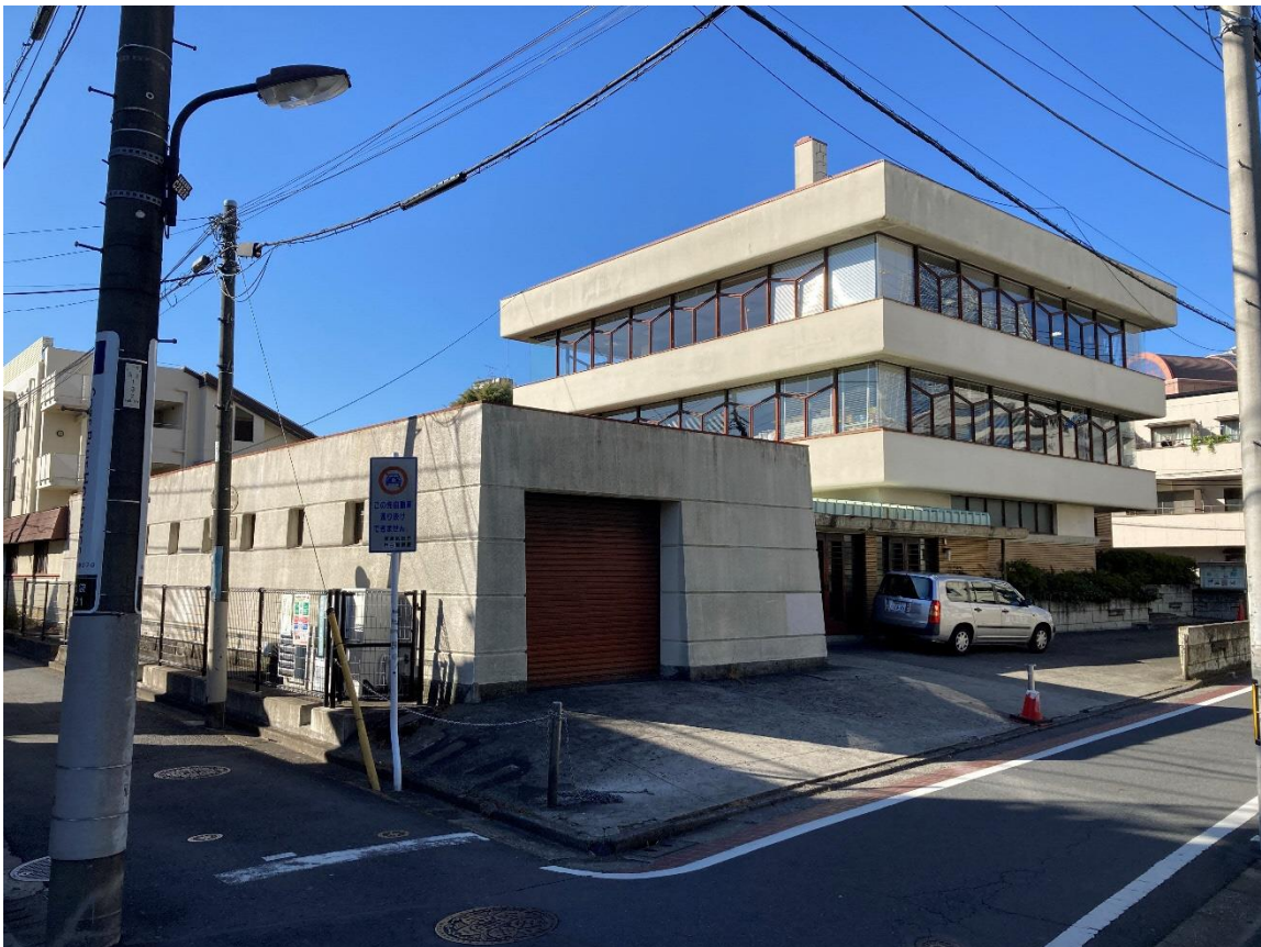
建物外観 婦人之友社社屋を南東より見る。手前は倉庫棟。3階建て部分が事務所棟。壁の多い倉庫棟と軽快な意匠の事務所棟が対比している。
