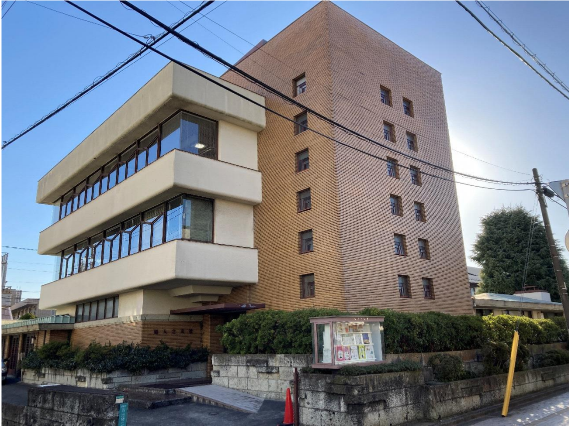
建物外観 北東より見る。事務所棟はガラスと白いリシンの腰壁部分で水平を強調している。右手の茶褐色のタイル張り部分は階段室、便所などがあり、構造のコアになっている。
