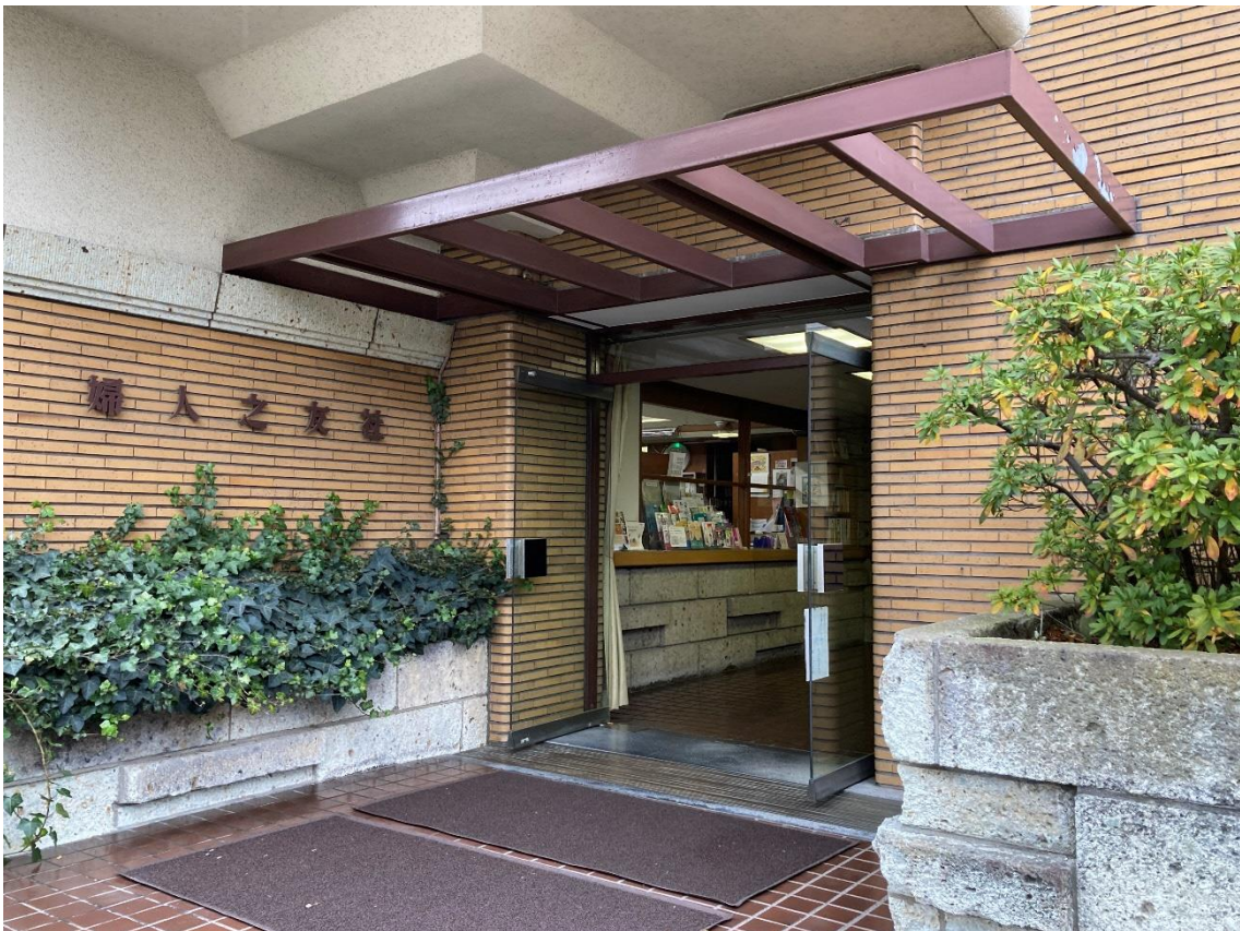
建物外観 婦人之友社玄関。大谷石を要所に使用し自由学園明日館との調和を計っている。
