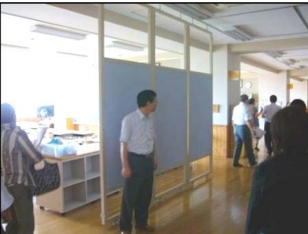
オープンスペースと教室部分の仕切りには可動式パーティションを設置。
