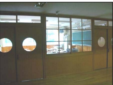
各室の扉は丸窓のガラスの種類（透明または曇りガラス）で、児童の使う部屋と使わない部屋を区別。
