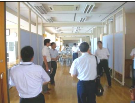
オープンスペースと教室部分の仕切りには可動式パーティションを設置。
