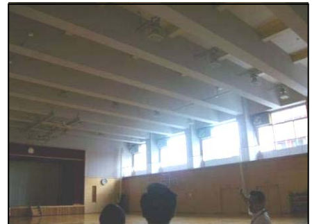
プールの下にあるため、梁が非常に太いつくりの小学校体育館。
