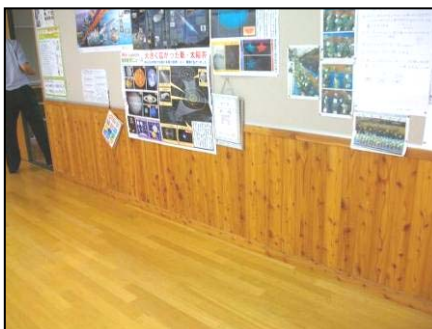
教室・廊下はすべてに間伐材を使用した腰板を用い、木の多い学校に。
