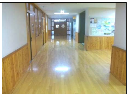
教室・廊下はすべてに間伐材を使用した腰板を用い、木の多い学校に。
