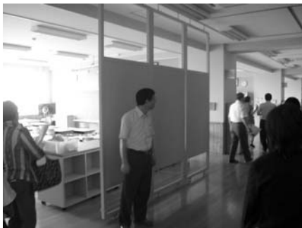
オープンスペースと教室部分の間には可動式間仕切りを設置
