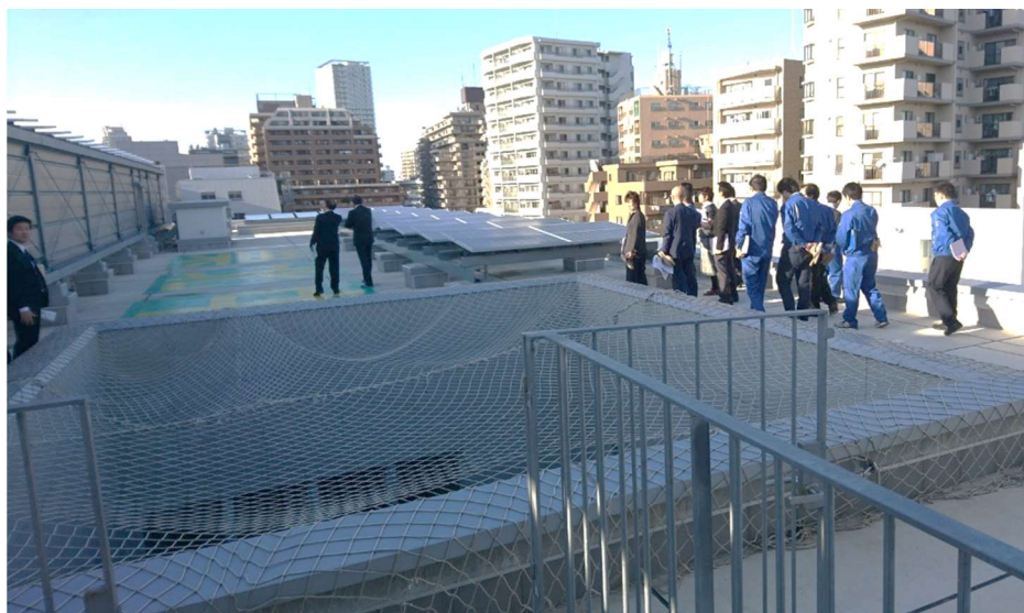
【屋上の吹き抜け開口部】
