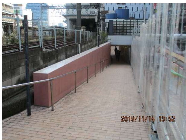
【西側出入口付近】
