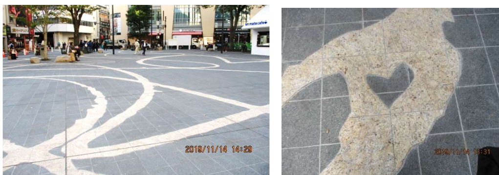
【黒御影石を切り抜き、白御影石を張った状態】
