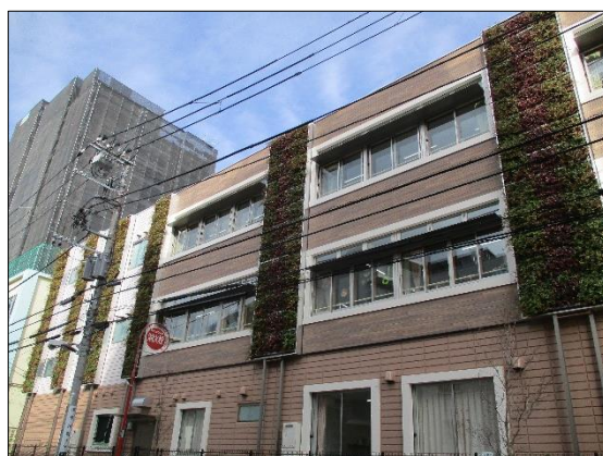
▲ 壁面緑化（南側）
