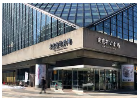
建物壁面にデザイン性のある広告物を設置（豊島区西池袋）
