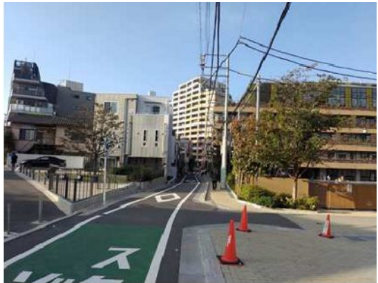
← 写真④ 補助82号線から救援 センター（池袋第一 小学校）につながる 沿道の整備 令和4年度 学校改築に伴う沿道 整備
