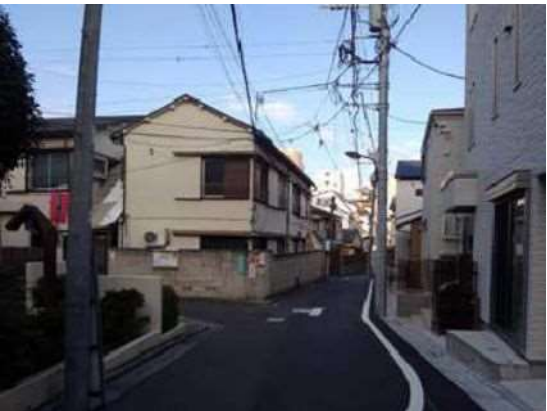
← 写真② 主要生活道路B4路線の 一部拡幅 令和6年度 幅員 2.4m～3.6m程度の 道路が続く。(写真右拡幅 部分 54.05 m 2 )
