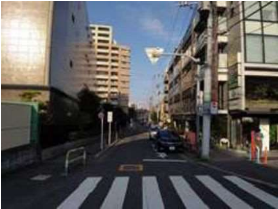
← 写真① 主要生活道路B4路線 整備済み区間 平成16年度 民間大規模マンション 開発と連携して区道を 付け替え、幅員8mの 道路として整備
