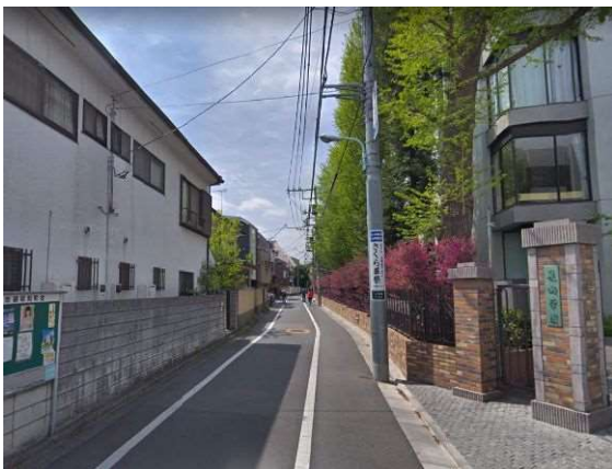
← 写真⑥ 主要生活道路B1路線の未拡幅の部分 学校改築に伴う沿道整備により幅員5mまで整備された。
