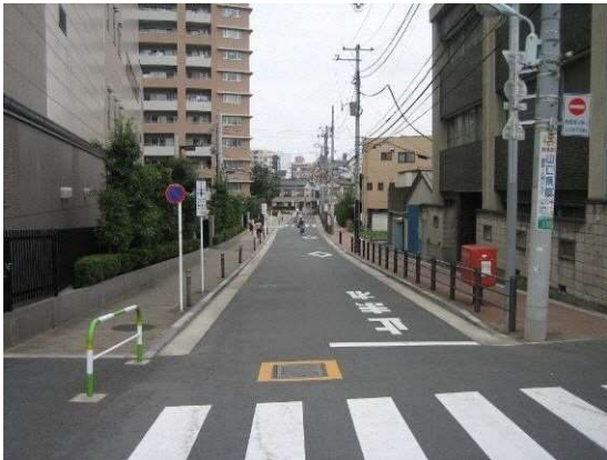
← 写真① 主要生活道路B4路線の拡幅部分 民間大規模マンション開発と連携して区道を付け替え、幅員8mの道路として整備した（平成16年度）。
