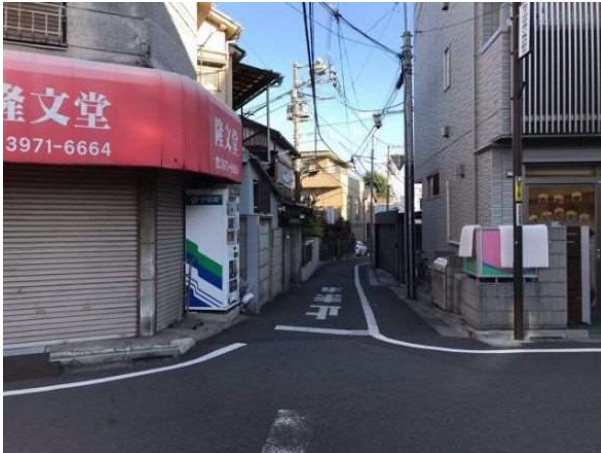
↑写真④ 整備検討路線④の未拡幅の箇所 現況幅員は 2.7m～4.0m。
