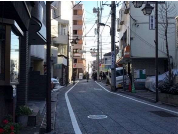
↑写真① 優先整備路線①の拡幅予定箇所 目白通りの交差部近くが幅員 5m程度に狭まっている。
