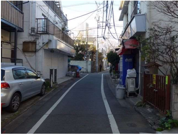
↑写真⑤ 整備検討路線⑤⑥の未拡幅の箇所 幅員 3.6m前後の道路が続く。
