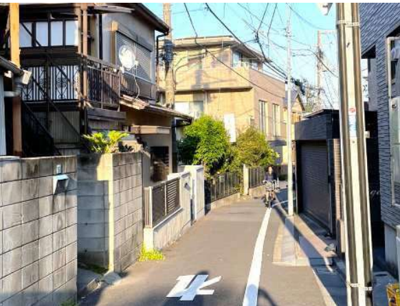
↑写真④ 整備検討路線④の未拡幅の箇所 雑司が谷公園と優先整備路線①を接続する 道路である。現況幅員は 2.7m～4.0m。
