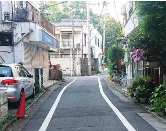
↑写真⑤ 整備検討路線⑤⑥の未拡幅の箇所 雑司が谷霊園と弦巻通りを接続する道路である。 幅員 2.7m～4.6m前後の道路が続く。
