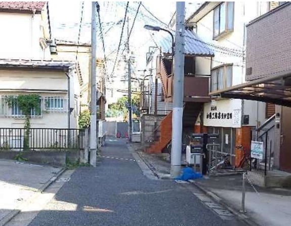
↑写真③ 優先整備路線③の拡幅予定箇所 近隣公園である雑司が谷公園につながる。 現況幅員は 2.4～4.0m。
