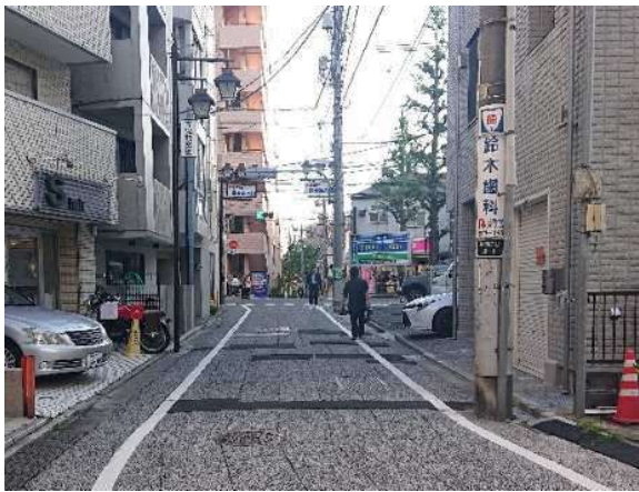
↑写真① 優先整備路線①の拡幅予定箇所 目白通りの交差部近くが幅員 5m程度に狭まっている。
