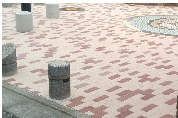
施工後のインターロッキング舗装
