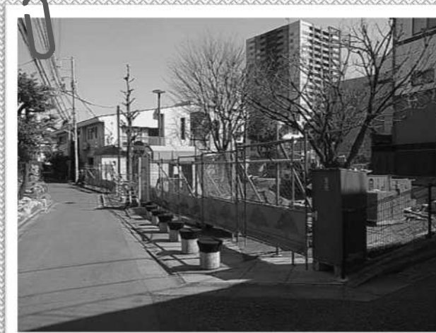
●中央公園改修工事の様子
