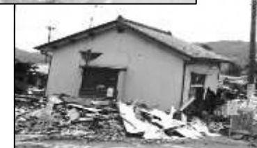
益城町、建物倒壊の様子
