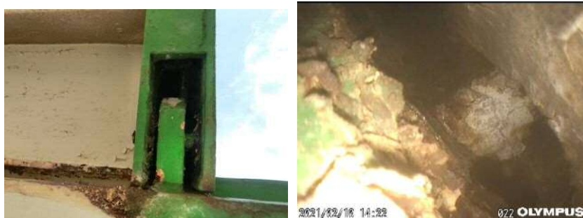
横断歩道橋のフック・ボルト部の腐食状況例
