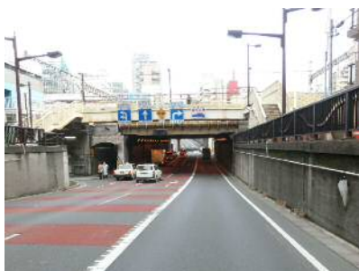
池袋南交差西側歩道橋
