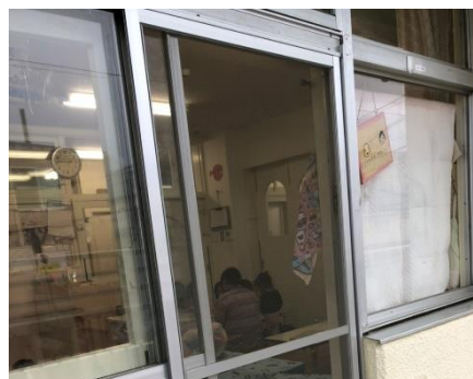
換気を行うために網戸を設置
