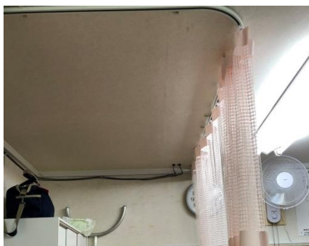
医務スペースに間仕切りカーテンを設置
