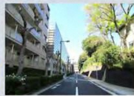
学習院橋の坂無電柱化 2020年3月完成
