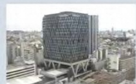
ビックリガード上空デッキ 2020年3月完成
