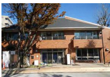
・公園と隣接の区民ひろばをつなぐデッキ整備（西巣鴨二丁目公園）
