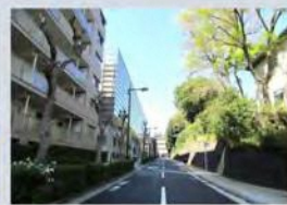
学習院壱の坂無電柱化 2020年3月完成
