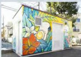
アートトイレ 2019年11月完成
