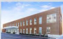
池袋保健所仮庁舎 2019年10月完成 ※2024年度に南池袋二丁目 C地区へ本移転予定
