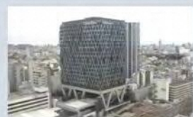
ビックリガート上空デッキ 2020年3月完成
