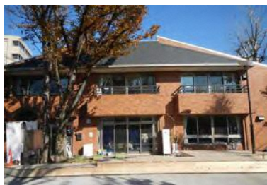
・公園と隣接の区民ひろばをつなぐウッドデッキ整備（西巣鴨二丁目公園）
