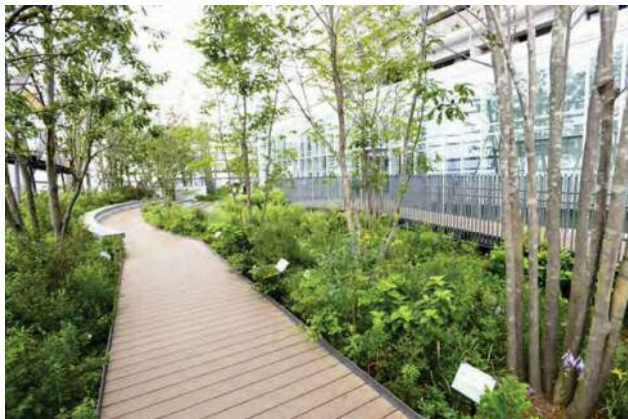
高層ビルの上緑化：雨水管理だけでなく、屋根を保護する効果なども 期待される（本庁舎 豊島の森）（資料：豊島区 HP）
