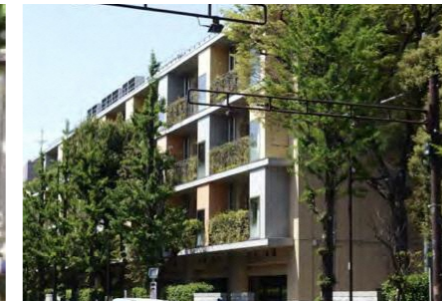
学校の屋上緑化・壁面緑化の推進（写真：目白小学校）
