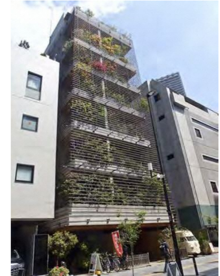
屋上緑化・壁面緑化の啓発と充実（写真：池袋東の寺院）
