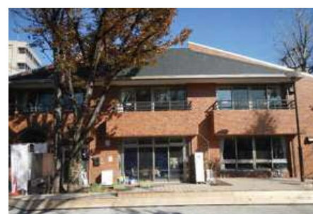
公園と隣接の区民ひろばをつなぐウッドデッキ整備（西巣鴨二丁目公園）
