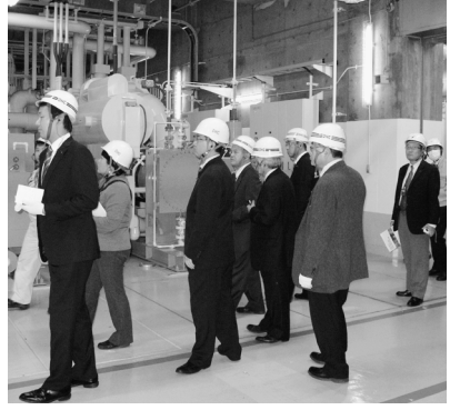
池袋地域冷暖房エネルギープラントにて
