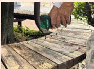
屋外で汚れがひどいため、高圧洗浄で汚れを落とします。木の裏までペンキを塗れるよう、ネジで固定されている木の板をひとつずつ外します。
