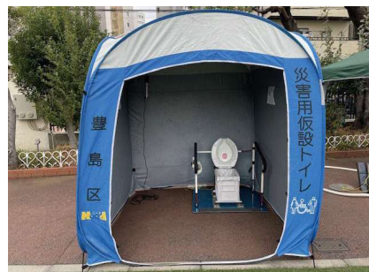
マンホールトイレ
