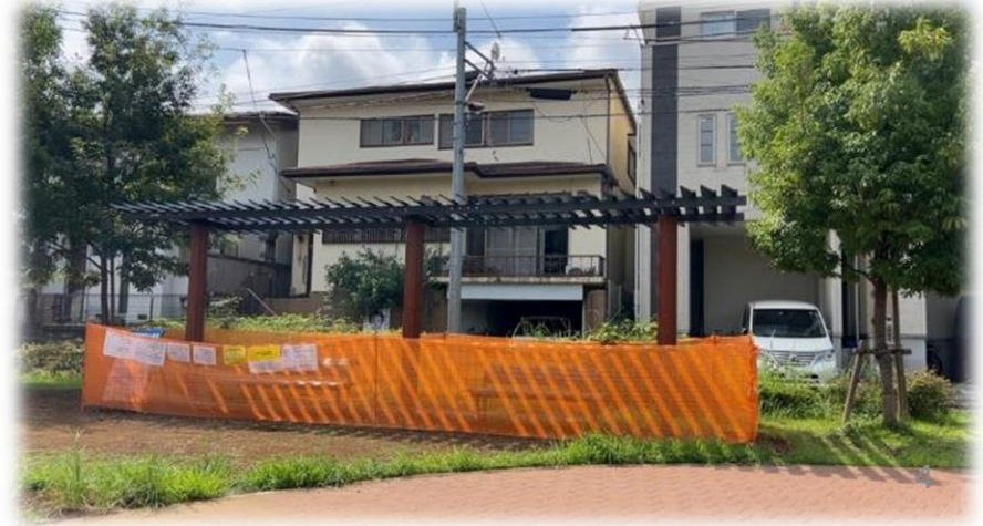
池本だんだん公園 日陰用パーゴラ設置
