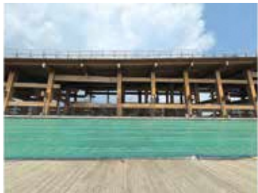
建設中の大阪・関西万博会場
