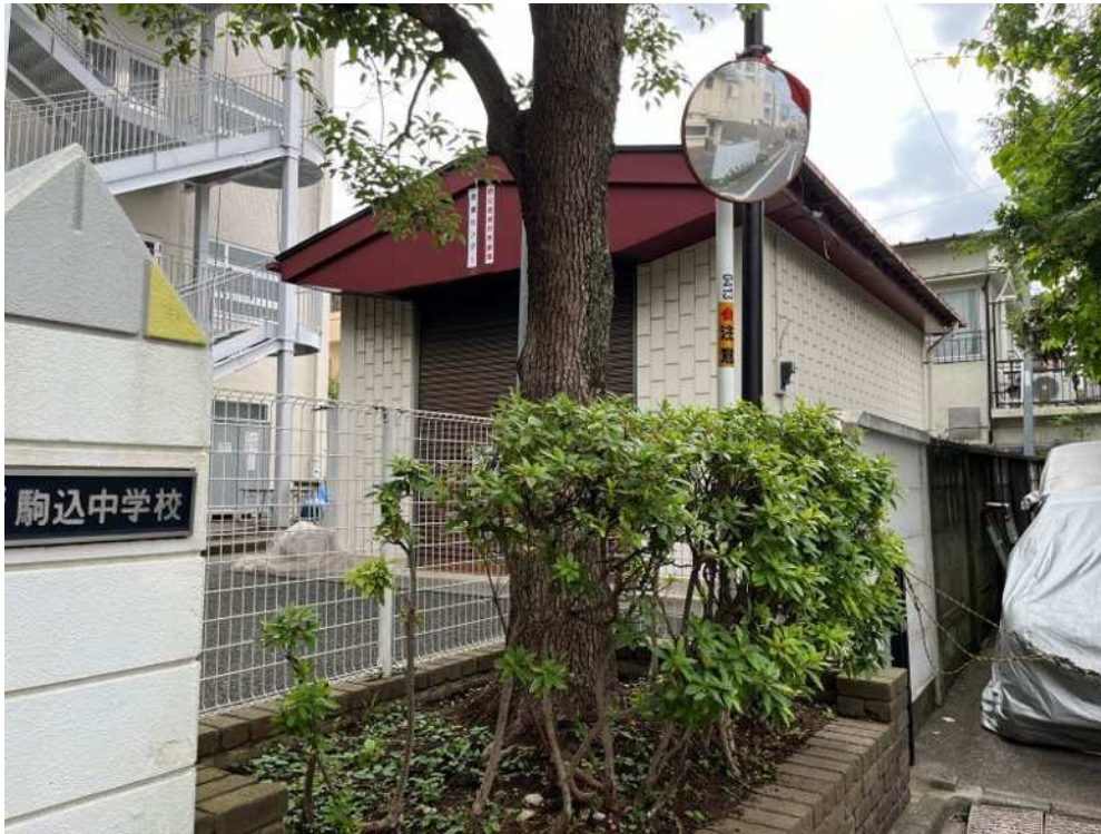
救援センター防災資機材格納庫
