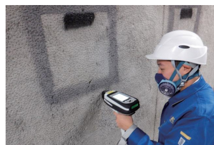
工事現場へ立入検査して 公害が起こらないように指導する
